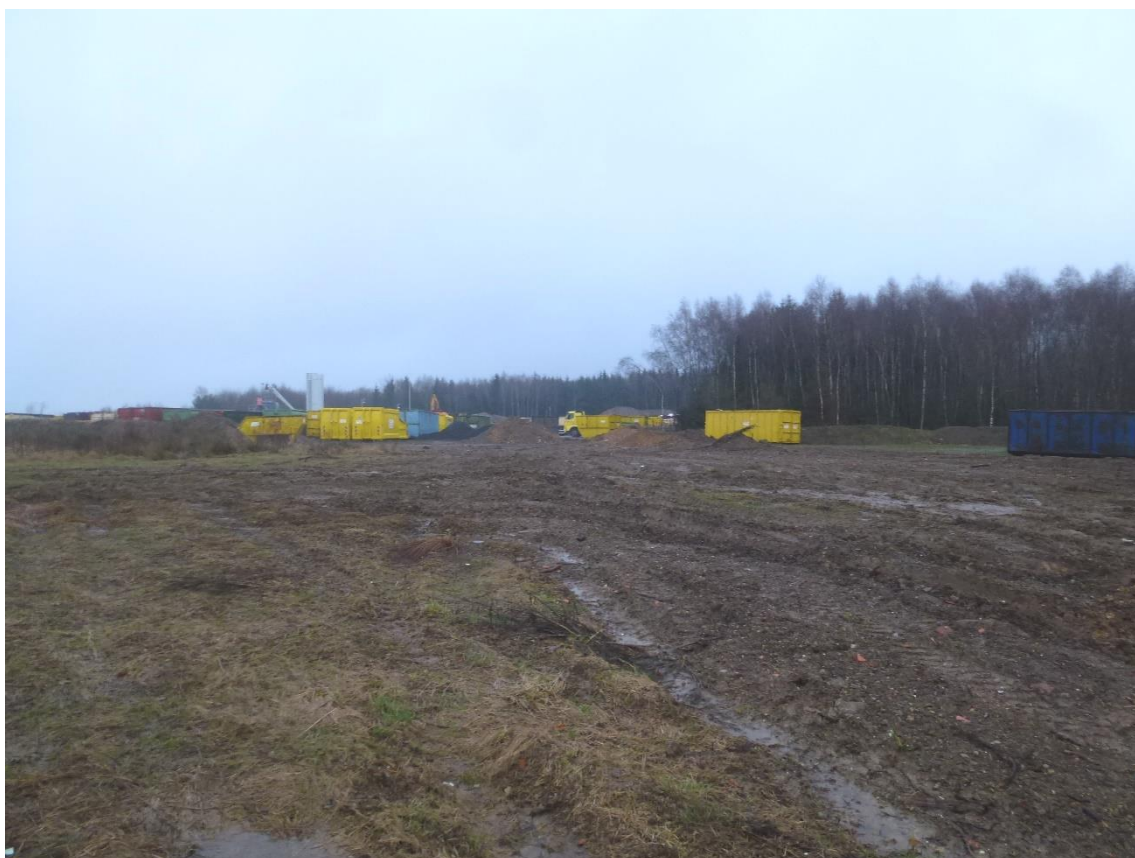
Blick von Südwesten auf das Industriegebiet, 07.03.2017
