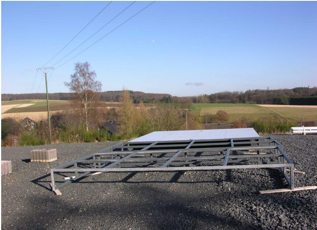
Abbildung 3: Lagerfläche auf Flurstück 101 (Aufnahme vom 05.02.2020)
