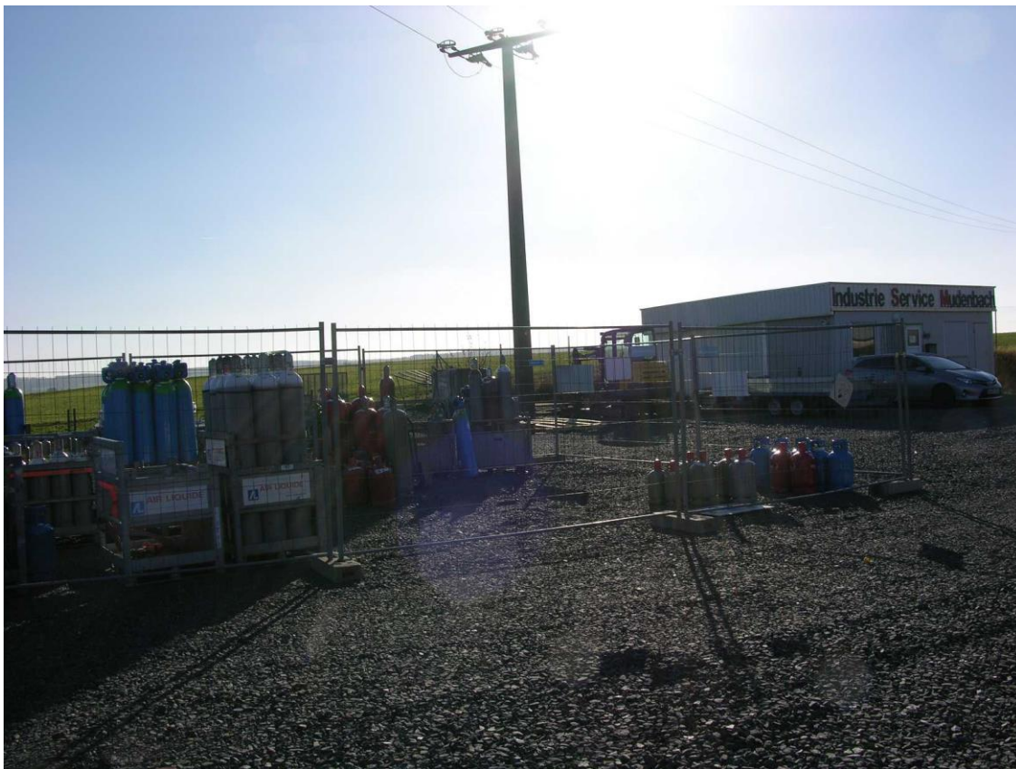
Abbildung 4: Lagerfläche auf Flurstück 101 und 102 (Aufnahme vom 05.02.2020)
