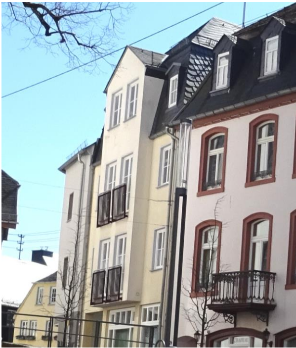
Positives Beispiel für die notwendige Anpassung der Fassadengliederung eines Neubaus an seine historische Umgebung.
