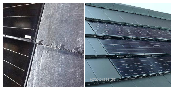
Solaranlagen sind, wie hier, möglichst bündig in die Dachfläche zu integrieren und der Dachflächenfarbe anzupassen.
