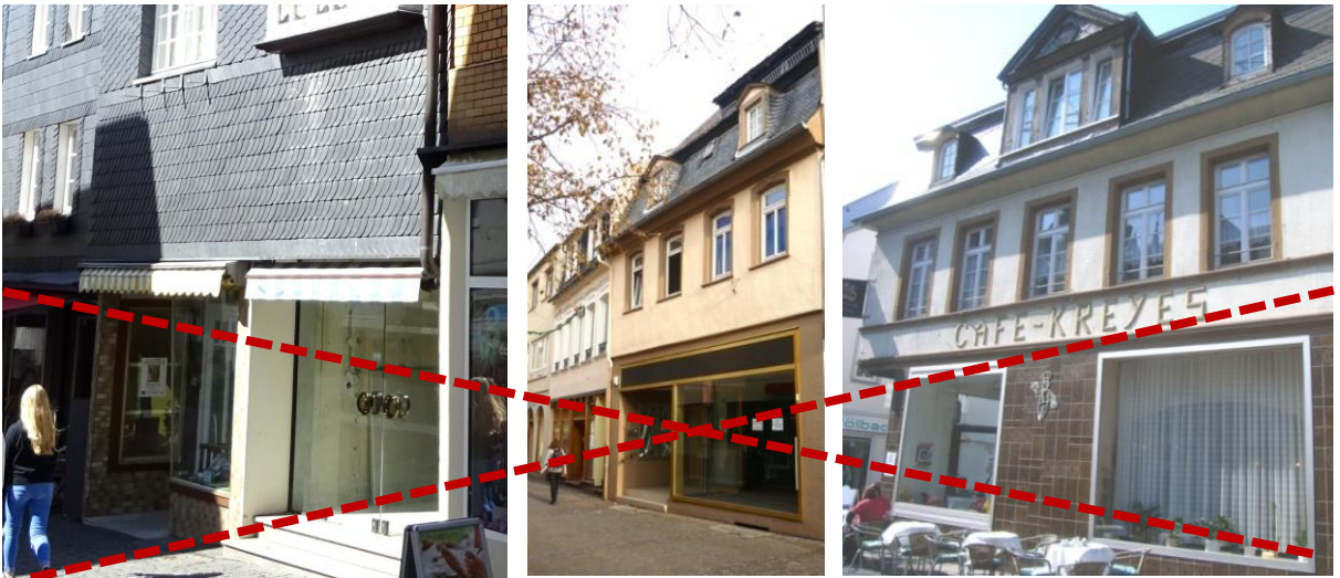
Fotos oben / Negativbeispiele: Durch den Einbau großflächiger Schaufenster in den Erdgeschossbereichen wurde das ursprüngliche Erscheinungsbild der Gesamtfassaden nachhaltig negativ verändert.
